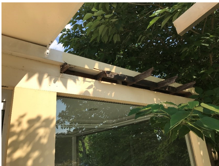
Αποκοπή παλαιών ξύλων και αποκατάσταση παρειάς
